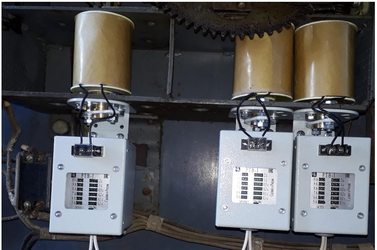
Рис. 22. Подключение обмотки к блоку управления.
