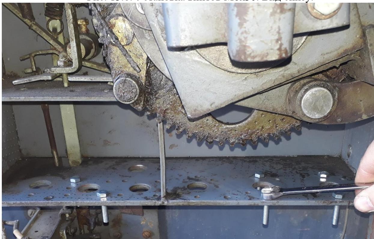
Рис. 13.б. Установка винтов М6х30. Вид снизу.
